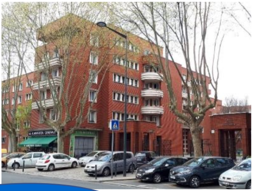
Entrée rue de Rome
